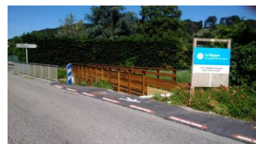
Crédit photo : MBonnefoy - Passerelle Péage de Oytier, mai 2020
